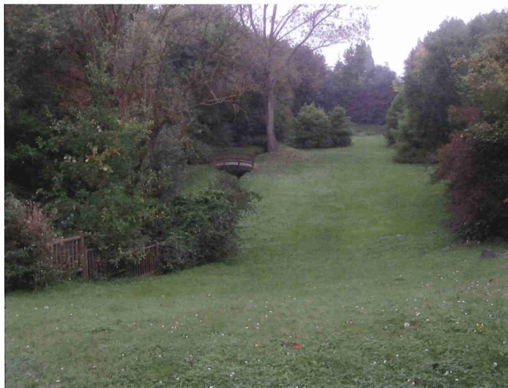
**Photo 6 : Ouvrage double fonction : aire de promenade et bassin à sec**
