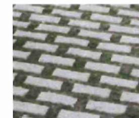
Pavage en béton avec ouvertures de drainage
