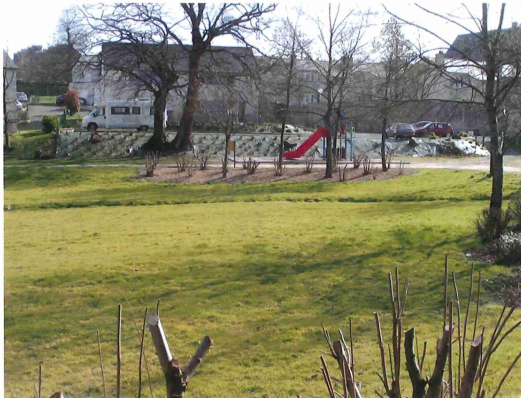
**Photo 5 : Ouvrage double fonction : aire de jeux et bassin à sec**
