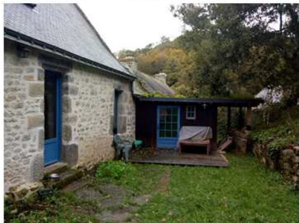
Figure 3: Sas d'entrée construit en 2020
