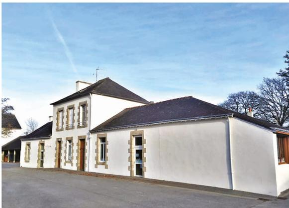
**A Saint-Yves**, le ravalement de l'école Teir Derven, incluant les cache-moineaux, les garde-corps, corniches et soubassements, a été réalisé par l'entreprise Raub pour un montant de 22 000 € H.T. Un lavage à haute pression, un traitement anticryptogamique, la reprise des éclats de béton et des fissures, la pose d'une couche de fixateur, ont été effectués avant l'application de deux couches de peinture pliolite et d'une couche de peinture acrylique.
