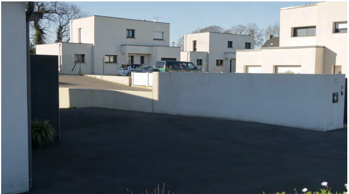
Parpaing et enrobé, une image fréquente de la densification des quartiers d'habitat individuel.
